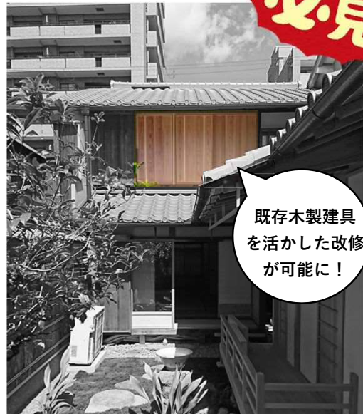
木製防火雨戸による防火改修
