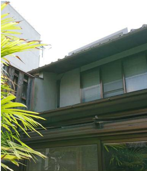
アルミサッシに改修された窓
