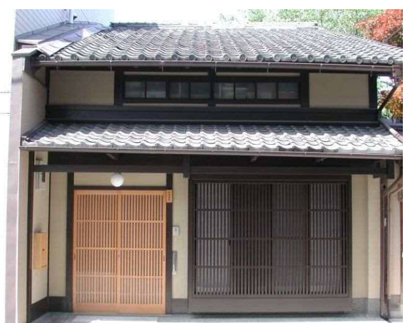
外観の整備後(土壁)
