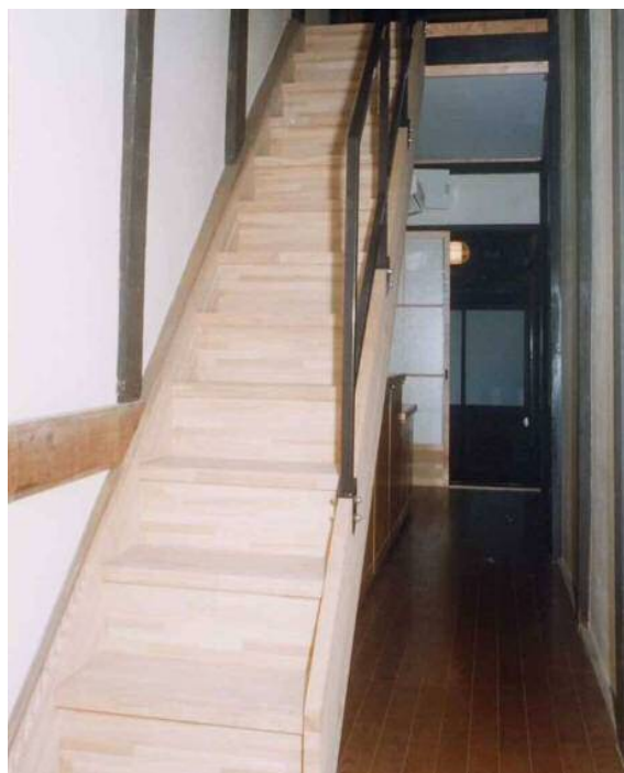
現行の規定に適合した緩勾配の階段
