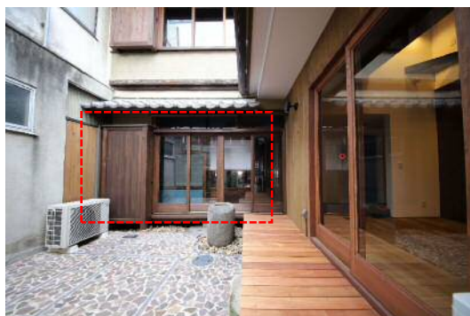
事例2 防火雨戸を設置した木枠の窓
